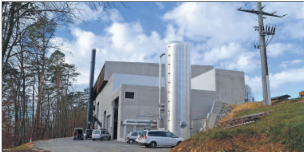
Porrentruy et son thermoréseau inspirent les Prévôtois. Hier, une étude de faisabilité d'un chauffage à distance a été présentée aux élus lors de la séance du Conseil de ville.
