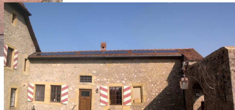
Boudry Le Château, valeur 0 (ZAL) Bâtiment classé
