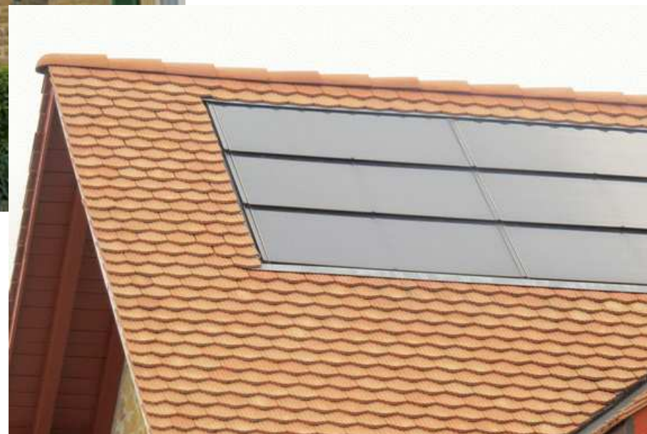
Marin-Epagnier Cité-Martini 7, valeur 1 (ZAL) Bâtiment classé
